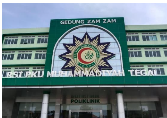
Gambar 3.1 Gedung Instalasi Rawat Jalan RSI PKU Muhammadiyah Tegal
